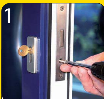
1 Die Zylinderhalteschraube herausdrehen
