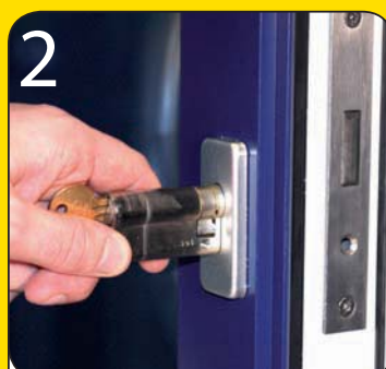
2 Den bestehenden Zylinder herausnehmen
