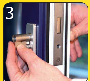
3 Den neuen ePAC Zylinder in die vorgesehene Öffnung einsetzen
